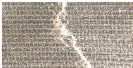
图 7 面板破坏形貌图
